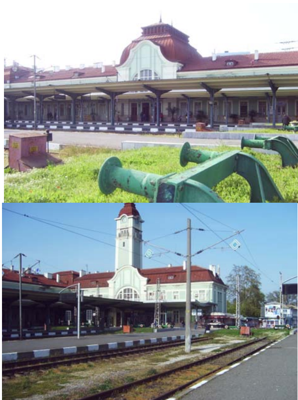
Фиг.2.Реставрация на гаровата постройка
