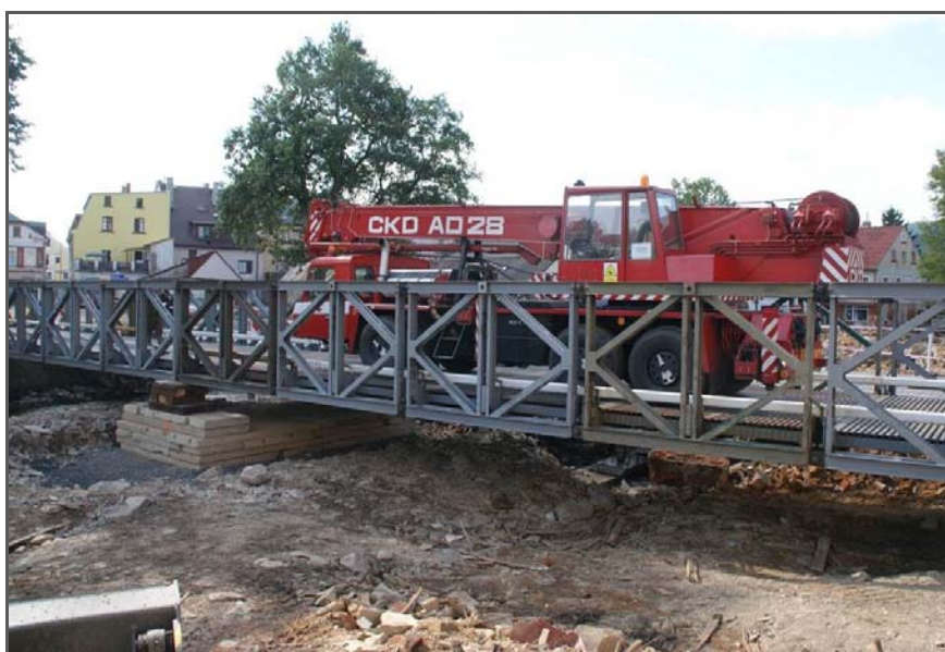
Фото 3. Испытание моста - нагрузка кран типа AD 28
