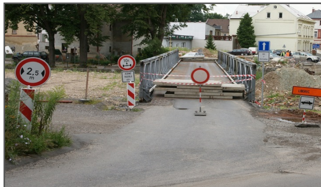
Фото 4. Грузоподъемность моста 40 тон и запрещено въезду машин с нагрузкой больше 10 тон/ось
