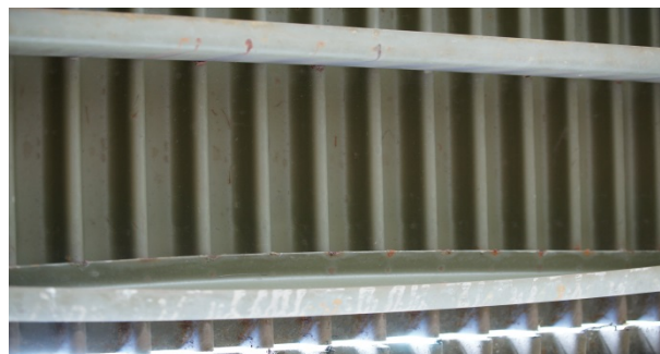
Фото 8в. Потеря устойчивости продольной балки
