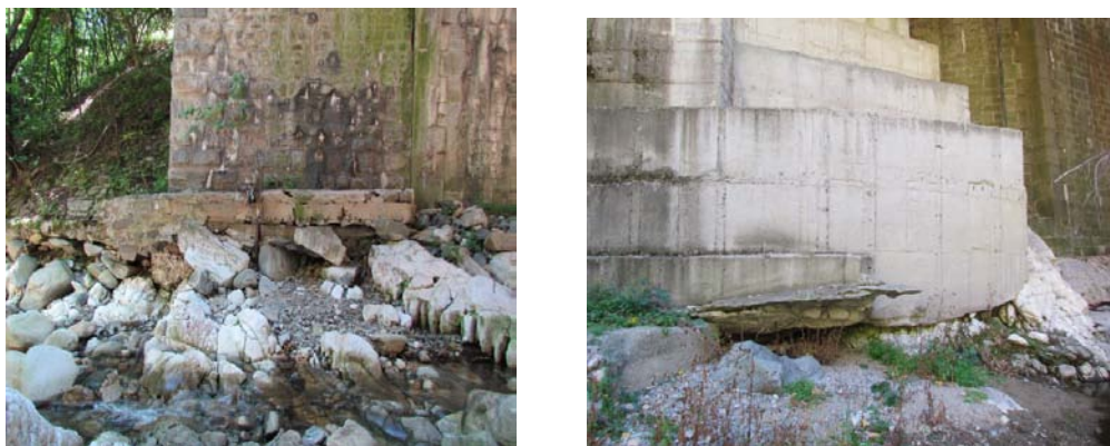
Фиг.1 Изравяне на мостови опори
