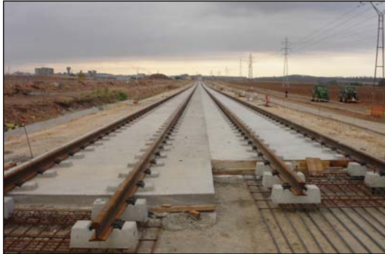
Фиг.7. Във Севиля за връзката между Alcalá и съществуващата линия 1 на метрото е изградена трамвайна връзка с 17км. безбаластов път по системата RHEDA CITY.
