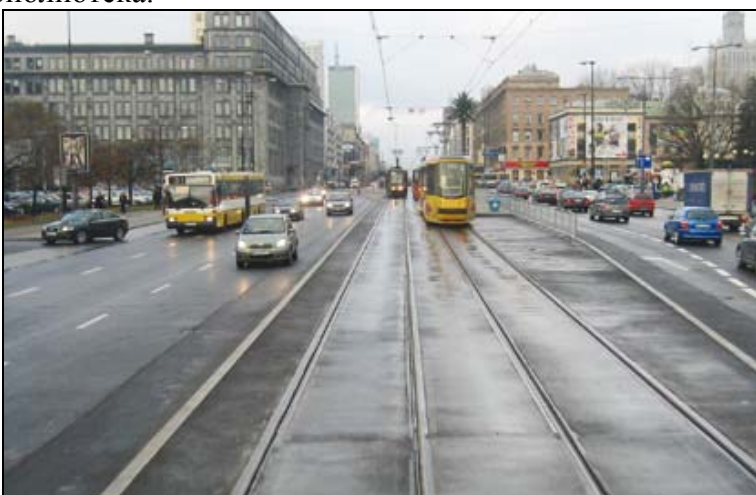
Фиг.6. Във Варшава за обновяване на съществуващите трамвай е използвана системата RHEDA CITY като са изпълнени 8км път.
