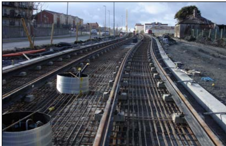
Фиг.7. Във Севиля за връзката между Alcalá и съществуващата линия 1 на метрото е изградена трамвайна връзка с 17км. безбаластов път по системата RHEDA CITY.
