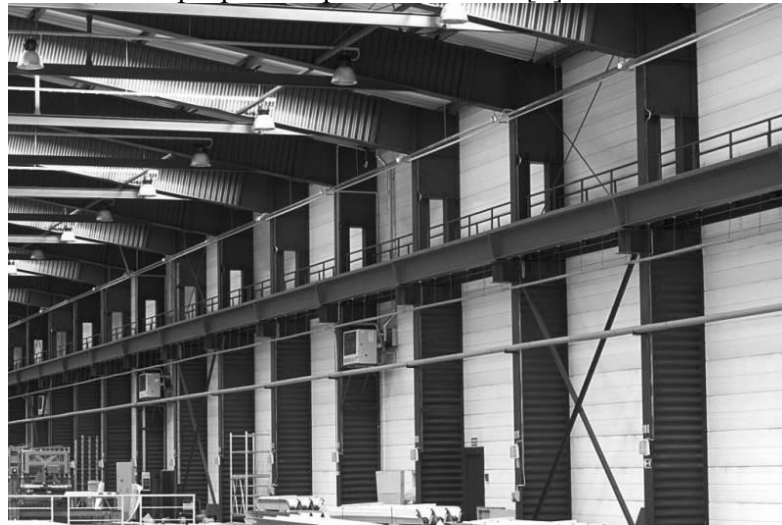
фиг. 1 Общ вид на подкранов релсов път
