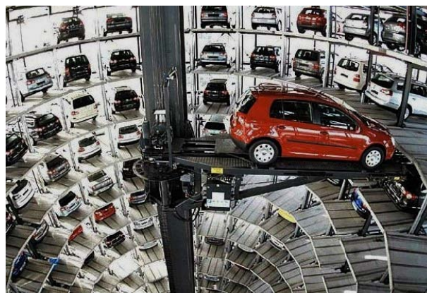
Фиг. 2. Паркинг с автоматизирана система за складиране на автомобили
