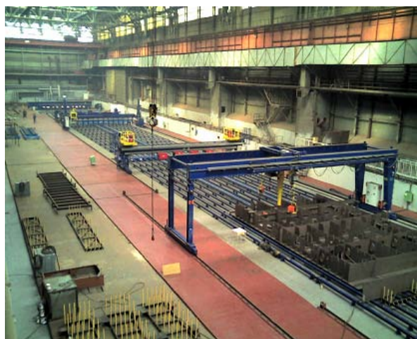
Фиг. 5 – автоматична лазерно-хибридна заваръчна и монтажна линия на фирмата Ingenieurtechnik und Maschinenbau GmbH
