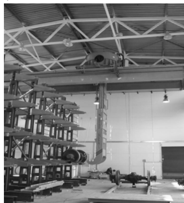
фиг.2 Щабел-кран за складиране на колооси на вагони с товароподемност Q=2,5 t проектиран и произведен от “Краностроене инженеринг” ЕООД
