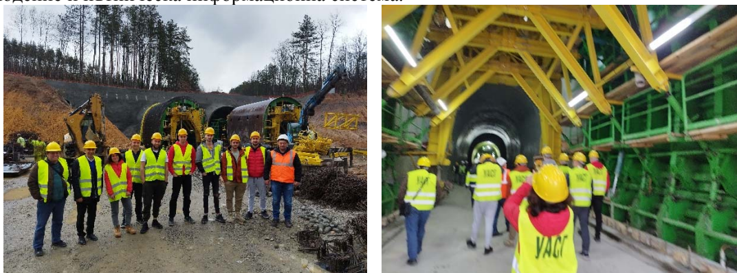
Фиг. 2. Строителство на два еднопътни тунела Д33Д "Джен-Дуй жп Елин Пелин"
