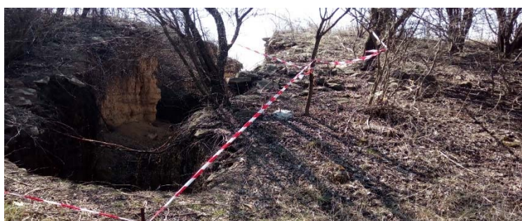
Фиг. 3. Снимка от участъка на скъсване на язовирната стена
