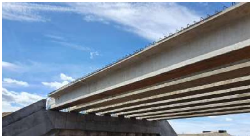
Фиг. 3. Деформация на греди вследствие на напрегането
