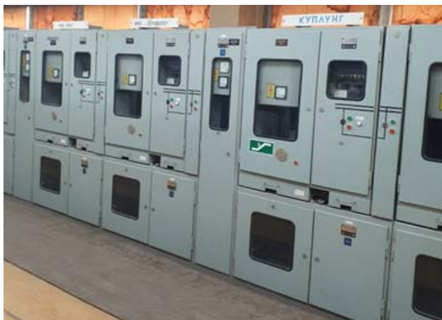
Фиг. 3. а. Общ вид на РУ 660 V DC, въведен в експлоатация през 80-те миналия век
