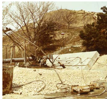
Фиг.9. Строителство на предварително напрегнати анкери в Балчик (1988) [2]
