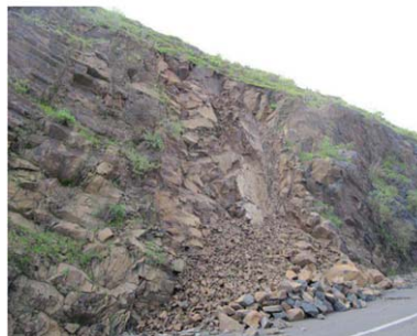
Фиг.15. Пренебрегване на опасността от свлачища на скални откоси.
