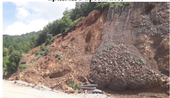
Фиг.13. Неразбиране на ролята на стоманените мрежи върху скалните откоси;
