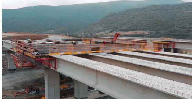
Фиг.3. Изграждане на моста над р. Струма
