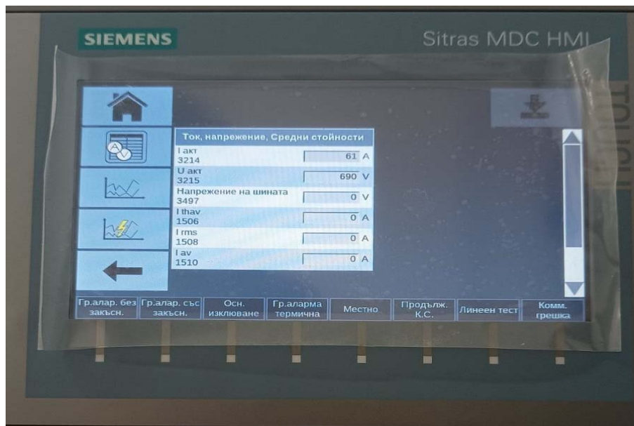
Фиг. 1. Операционен панел на СА показващ реално измерени стойности на избраните величини
