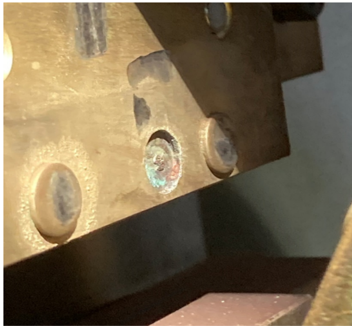
Фиг. 2. Шинна система на тунелен разединител 4000А
