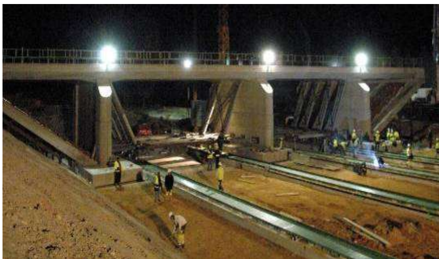
Фиг.5 . Технологията AUTOFONCAGE
