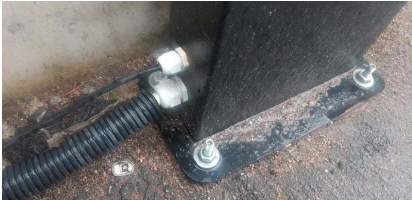
Фиг. 7. Зарядна станция „ECOFACTOR“ – анкериране, захранване и комуникации
