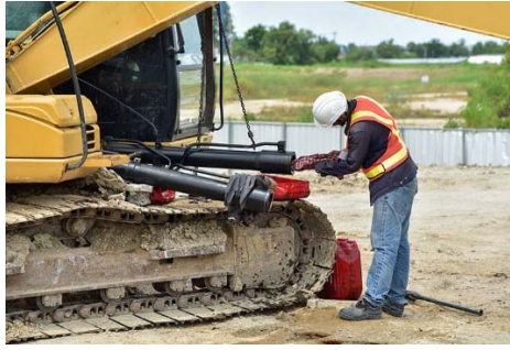
Фиг.4 Ремонт на верижен багер
