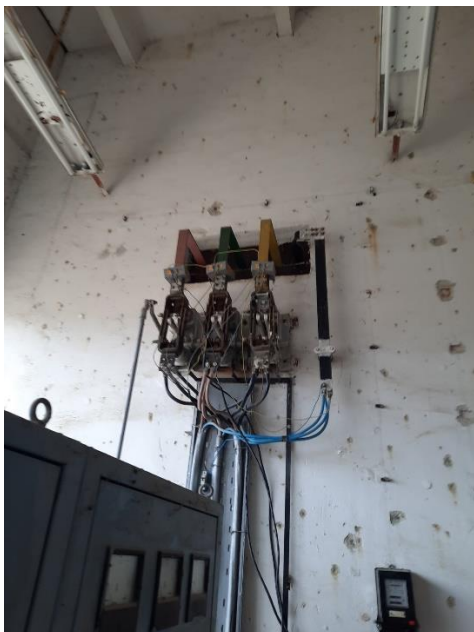
Фиг. 3. Схема на свързване на токови трансформатори 800/5
