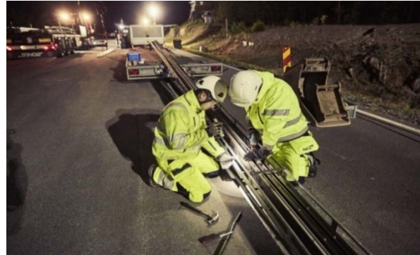
Фиг. 3. Полагане на контактна релса
