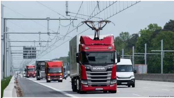
Фиг. 10. Магистрала оборудвана с контактна мрежа
