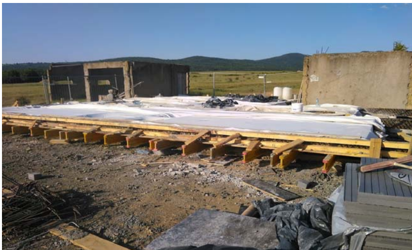
Фиг. 5 Грижа за пресните стоманобетонни елементи.
