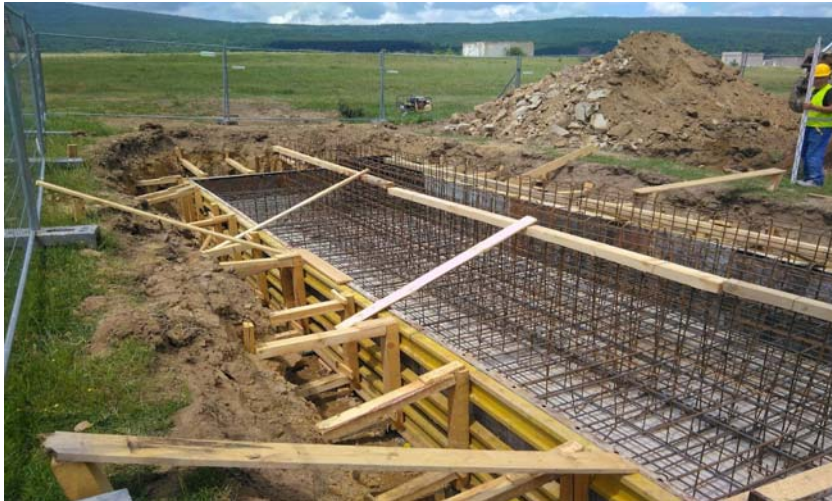
Фиг. 4 Фундаментни чашки- кофраж и арматура.
