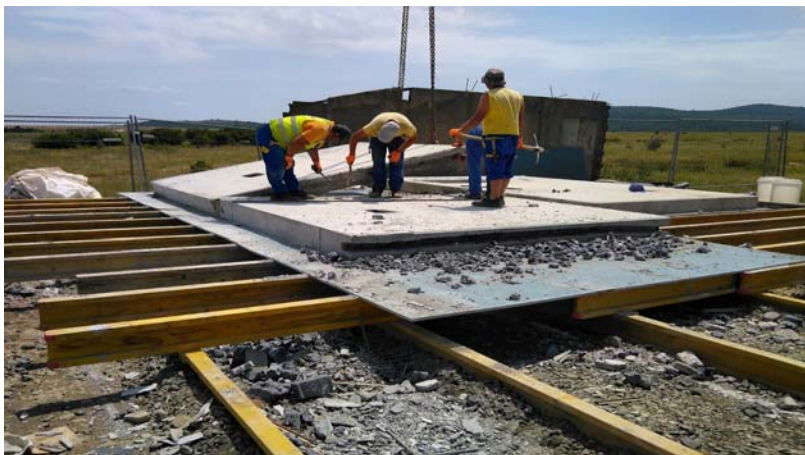
Фиг. 9 Отлепване на елементите от площадката за изпълнението им
