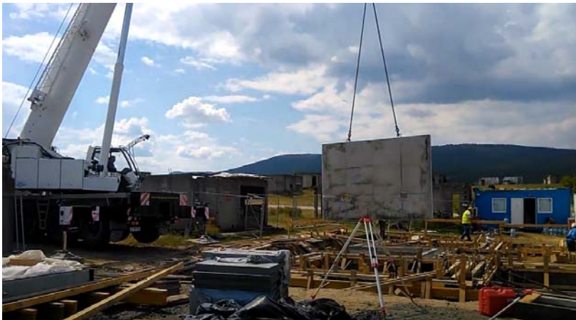
Фиг. 6 Монтаж на стоманобетонните елементи.
