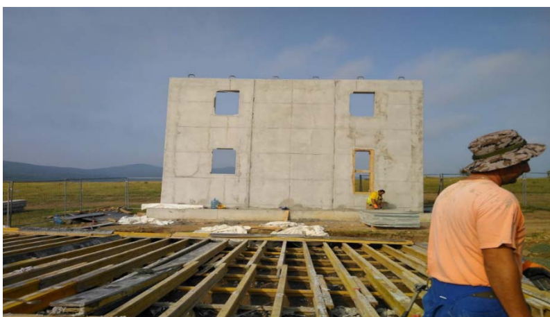
Фиг. 8 Монтирана стена от сглобяеми елементи пред площадката за изпълнението им.
