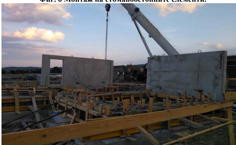
Фиг. 6 Монтаж на стоманобетонните елементи.
