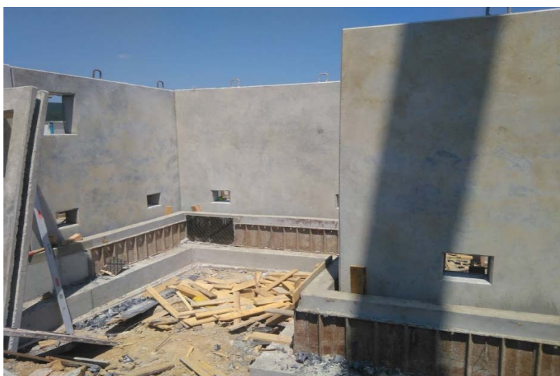
Фиг. 10 Монтирана фасада от сглобяеми стоманобетонни елементи.
