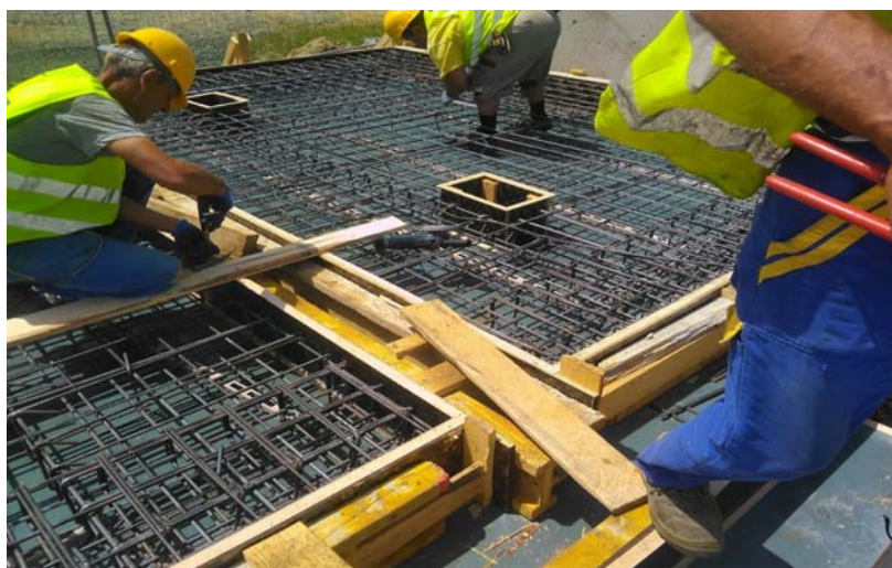
Фиг. 2 Армиране на стоманобетонните елементи.
