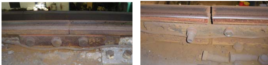
Фиг.8 и Фиг.9. Изгледи на наставови връзки за подкранови релси тип KR70
