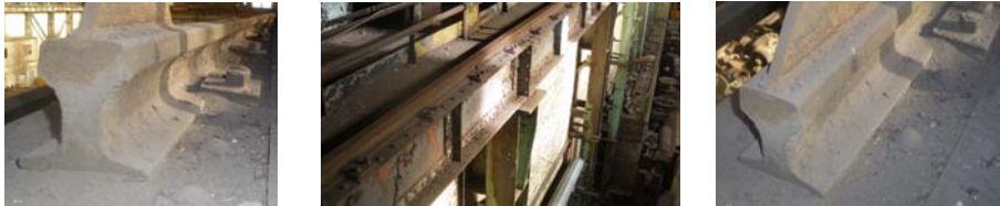
Фиг.5, Фиг.6 и Фиг.7. Изгледи на напречно сечение на подкранова релса тип KR70
