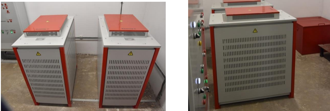
Фиг. 3. Компенсиращи шунтови реактори в ТПС 26А
