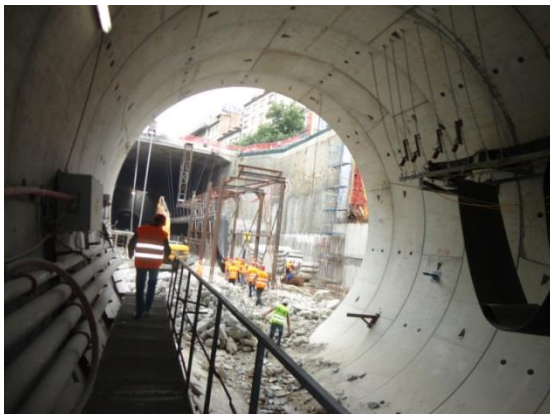
Фиг.8. Тунел направен от тунело-пробивна машина
