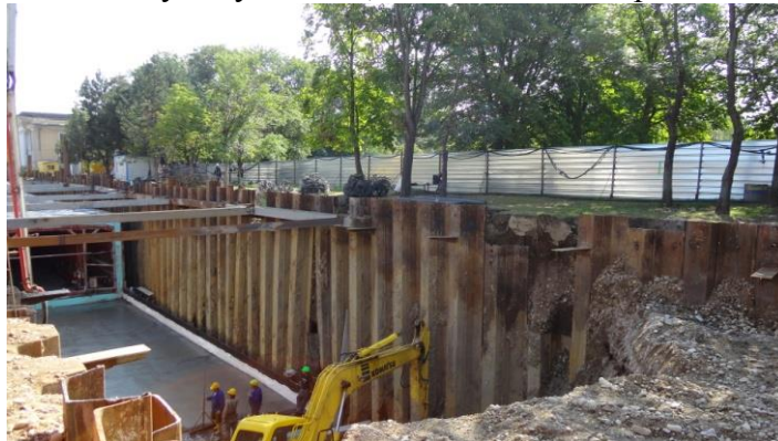
Фиг.5. Тунел в комплекс „Младост“ укрепен с шпунтови профили
