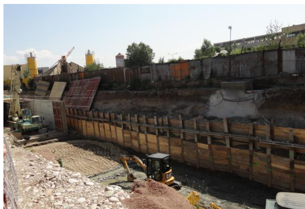
Фиг.4. Укрепване тип „Берлинска стена“ - Метални колони с дървени стени, използвана за укрепване на изкопите
