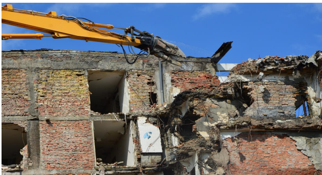
Разрушаване хотел „Сердика“ гр. София
