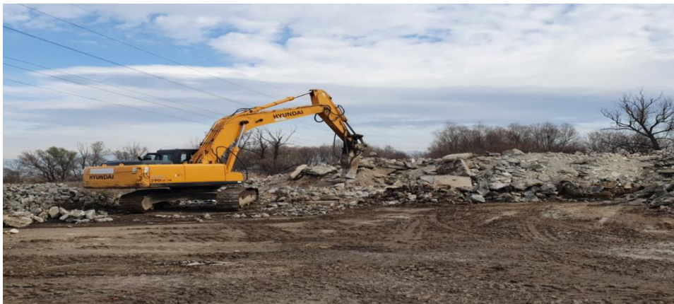
На площадката се извършва допълнително натрошаване с багер с хидро-чук.
