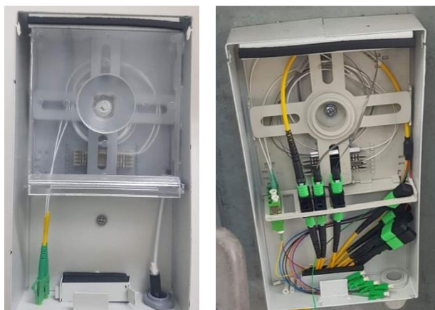
Фиг. 1в Видове крайни разпределителни кутии
