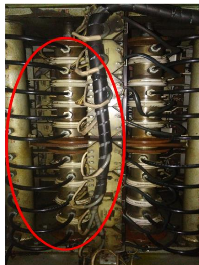
Фиг. 1 Разположение на диодите в токоизправителя на котвените намотки
