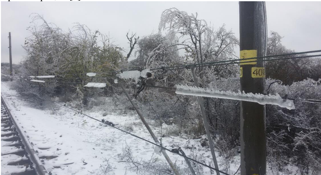
Фиг. 1. Обледяване на КМ в участъка Разград-Хитрино
