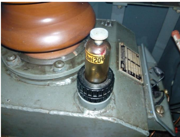
фиг. 3 Трансформатора за високо напрежение
