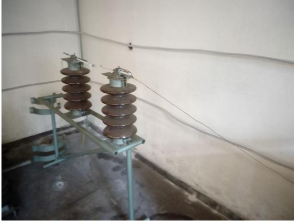
фиг. 1 Поставка на високоволтовите изолятори
