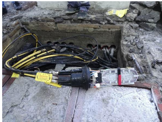
а) б) Фиг. 1-а) Оптична муфа с кабел G652и кабел за вътрешно полагане ; б) Optical RACK
