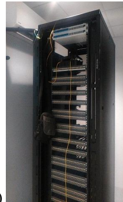
а) б) Фиг. 1-а) Оптична муфа с кабел G652и кабел за вътрешно полагане ; б) Optical RACK
