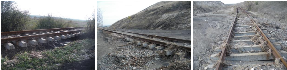
Сн.1÷3. Индустриален жп коловоз в индустриална зона Бургас
