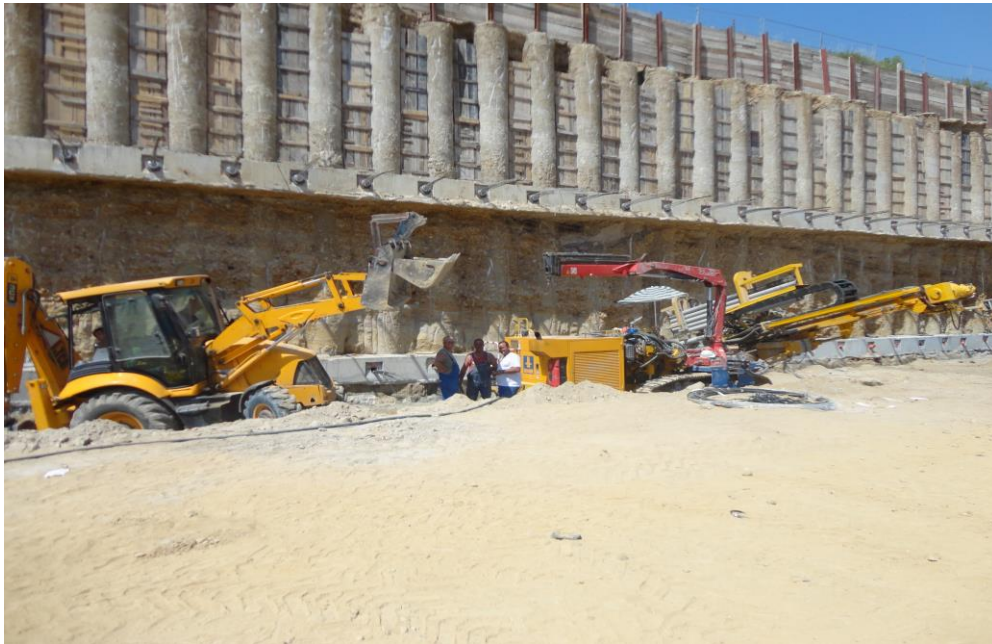
Фиг. 1. Процес на набиване на втори ред анкери при укрепване с пилотна стена
