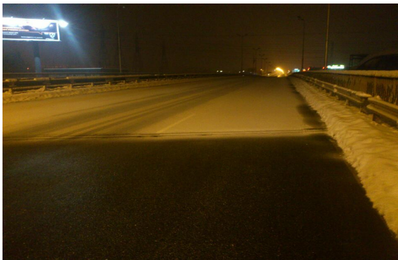
Софийски околоръстен път – мост над път III – 181
