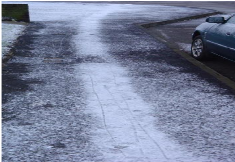
Преминаване на водопровод под уличната настилка – понижава температурата.
