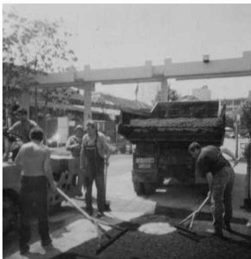
Фиг.5 Мястото на ремонта в МЕЛ София
