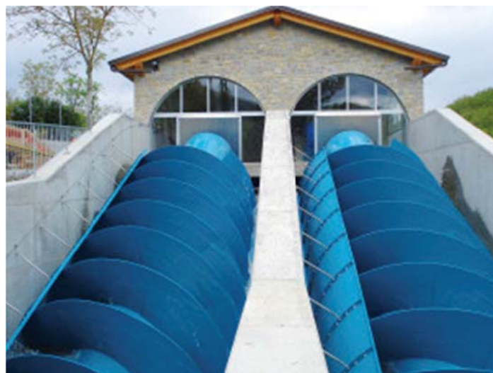
Фиг. 2. Общ вид на двигателната система на ВЕЦ с архимедов винт.
