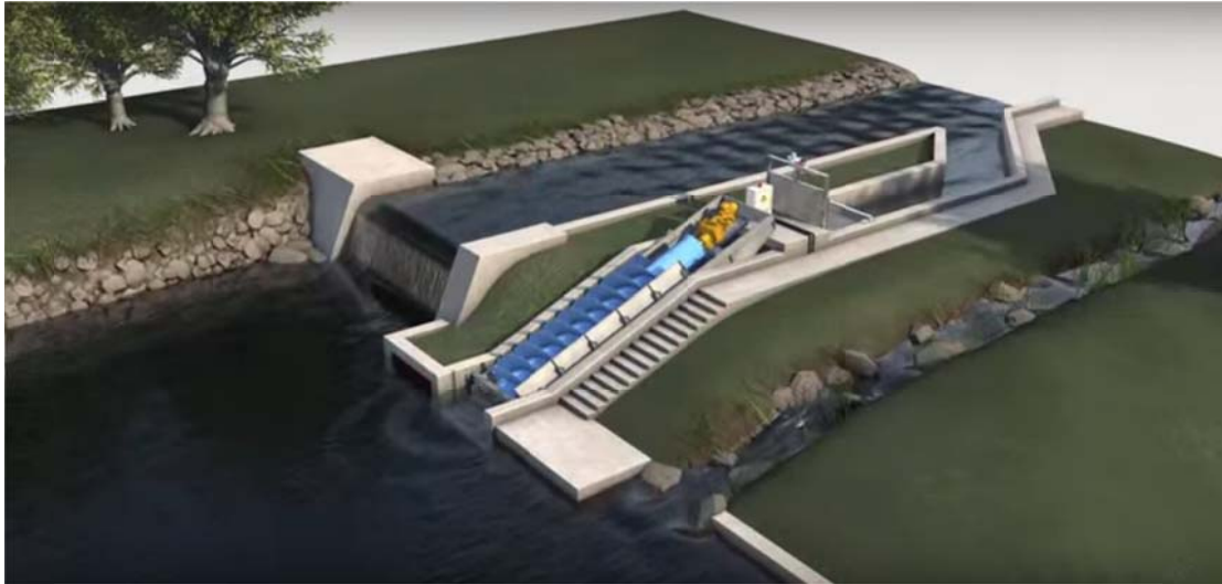
фиг.4. Проект на водно електрическа централа с архимедов винт .
