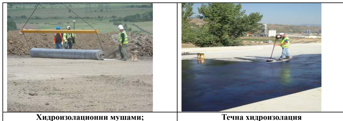
Фиг.3 Видове хидроизолационни системи на мостови конструкции
