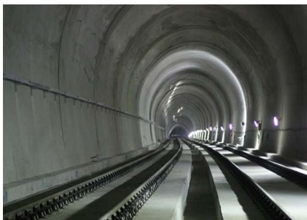
Фигура 3: Безбаластова конструкция Vanguard в Китай [5]
