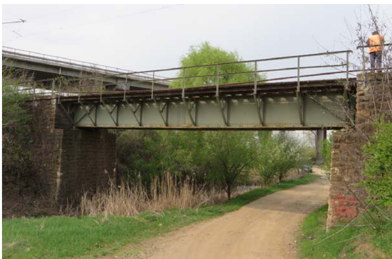
Фиг.1 . Мост по жп линия София Карлово на км. 22+730 до гара Яна.
