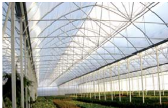
Фиг. 6 Дъгообразна лека фермова конструкция. (Полиетиленово фолио) Light dome-shaped construction of a farm (polyethylene foil)
