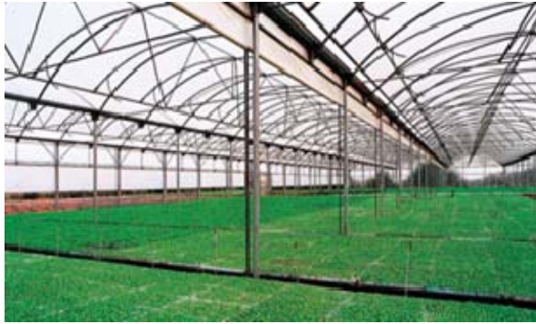
Фиг. 5 Лека рамкова конструкция. (Полиетиленово фолио) Light frame construction (polyethylene foil)
