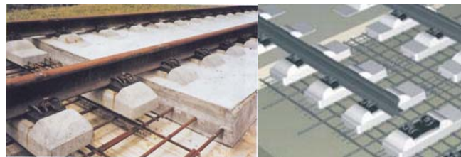
Фиг. 2.2. Конструкция „Rheda 2000”
