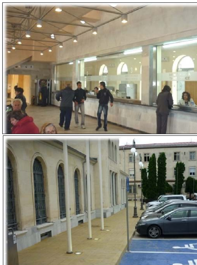
Фиг.4 След ремонта на г. Плевен
