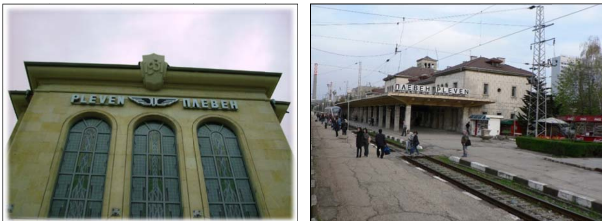
Фиг.3 Гара Плевен преди ремонта
