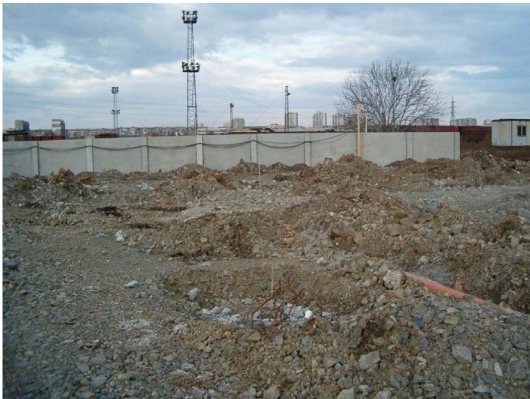
Фиг.4. Положена засипка от трошен камък и набивните пилоти с разбитите глави на пилотите
