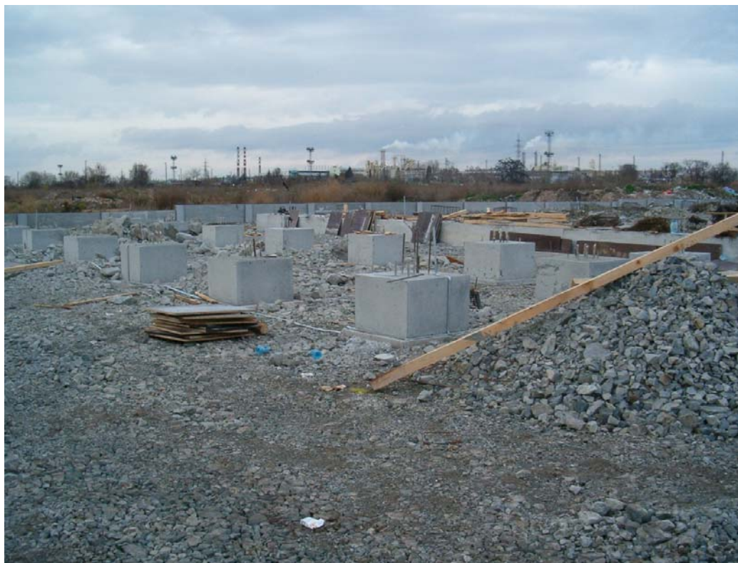
Фиг. 6. Изпълнен ростверк на пилотните фундаменти.
