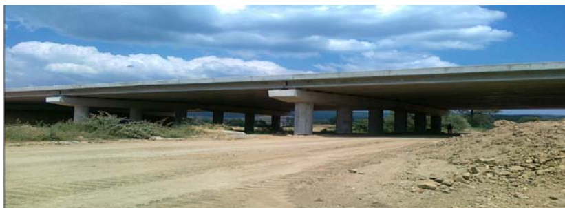
Снимка 1. Изглед на триотворен пътен надлез, фундиран върху изливни пилоти
