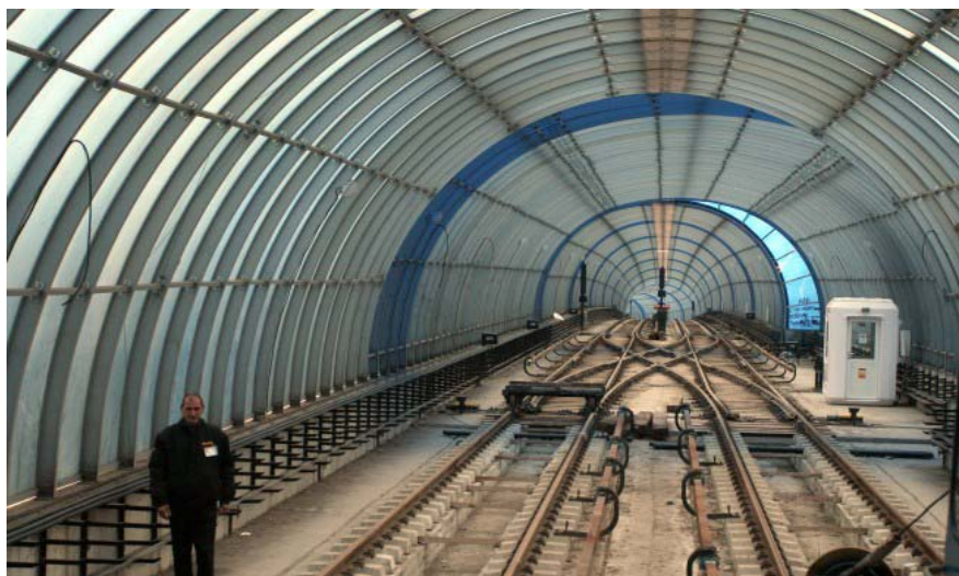
Фиг.2 Двупътен надземен покрит участък с бретел
