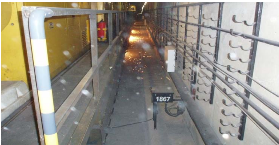
Фиг.5 Машина за шлайфане на SPENO по време на работа в тунела
